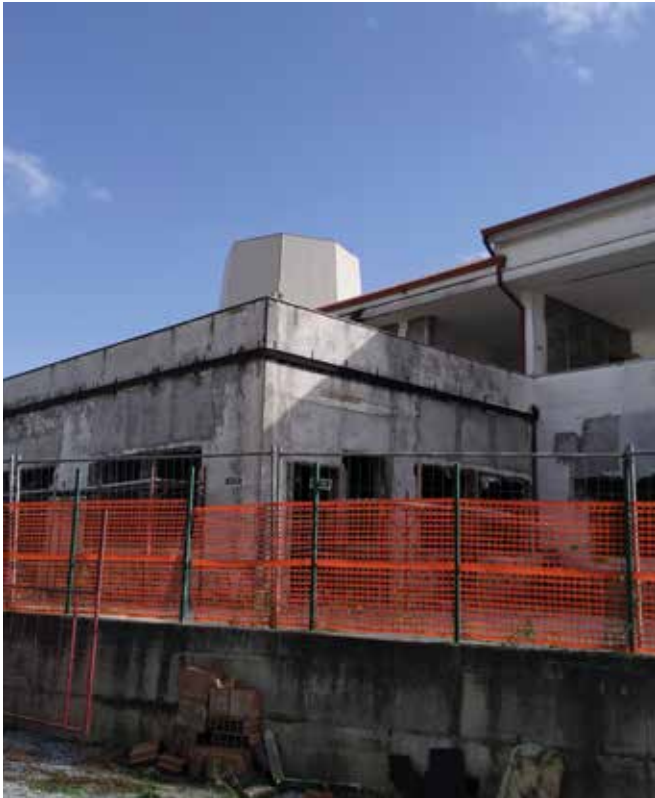
Lavori in corso della struttura sociale
