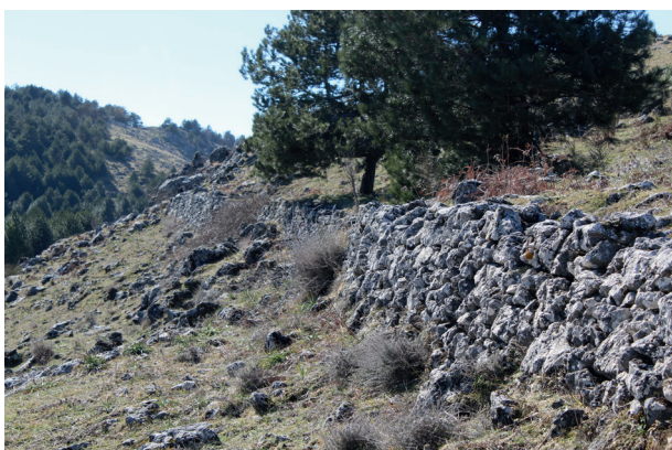
Fig. 15 - Muri perimetrali a ridosso dei dirupi - Perimeter walls abutting the cliffs.
